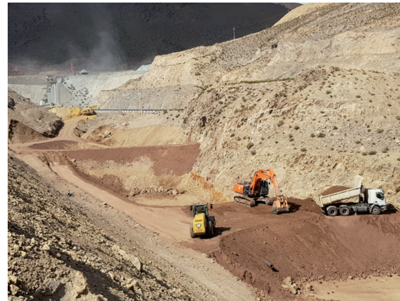
Construcción de diques para regular flujo superficial en época de lluvias.
